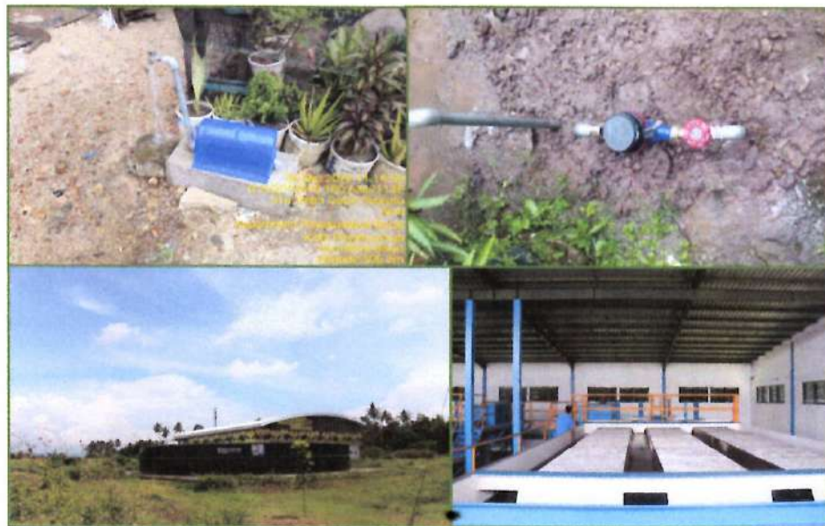
Gambar 15 Instalasi/ Pembangunan Sambungan Rumah (Atas), Water Treatment Plant (Bawah)
