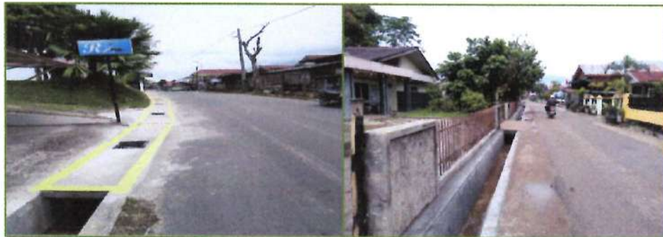
Gambar 21 Pembangunan Jalan Lingkung Taratak Padang Kampuang (Kiri)
